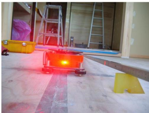
畳の寸法測りの実際の様子を一般の方が見る事は無いと思いますが一昔前は糸を十字に張り計測したのもですが今では糸の代わりにレーザーを使用して計測いたします。
