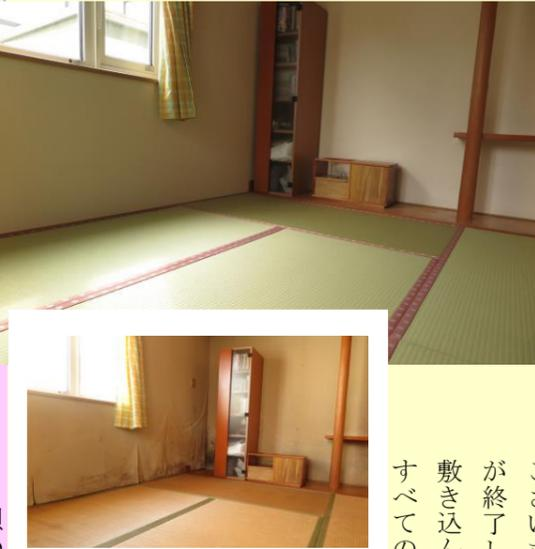
今回のプチリフォームは施主様のご希望により短時間での施工でした。クロス職人がクロスを剥がして新しいクロスを貼っている間に畳を工場へ持ち帰り畳表替え作業開始でございます。クロスの張替えが終了した時刻に畳を搬入し敷き込んで完了です。すべての作業を終えた和室はどうでしょう
